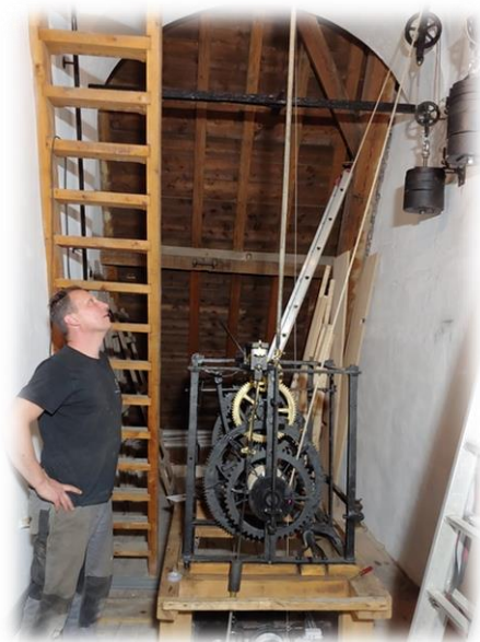
Restaurator Ralf van Veghel kijkt met een blik van voldoening op het eindresultaat. Opnieuw is een prachtig stuk cultureel erfgoed voor het nageslacht behouden.
