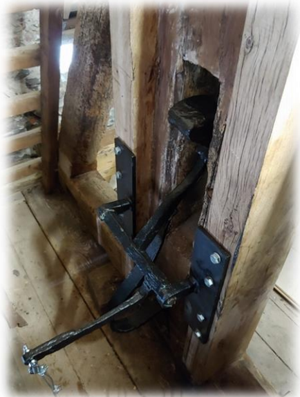
De slaghamer met terugslagveer gemonteerd aan de buitenzijde van de staander van de gerestaureerde klokkenstoel
