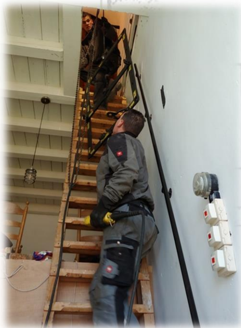
Het bovenste uurwerkframe wordt omhoog gehesen.
