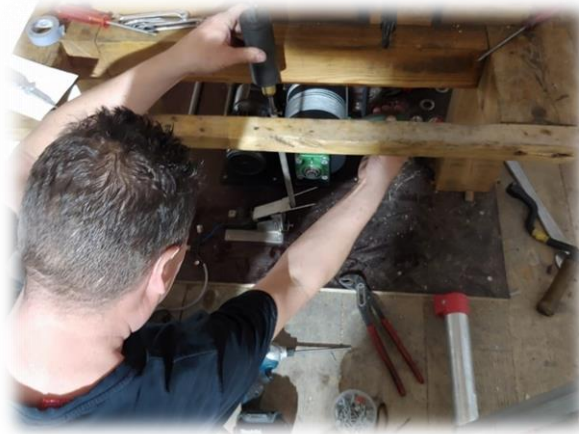
De plaatsing van het slingervangstelsel onder de slinger van het gaandwerk, vereist de nodige precisie.
