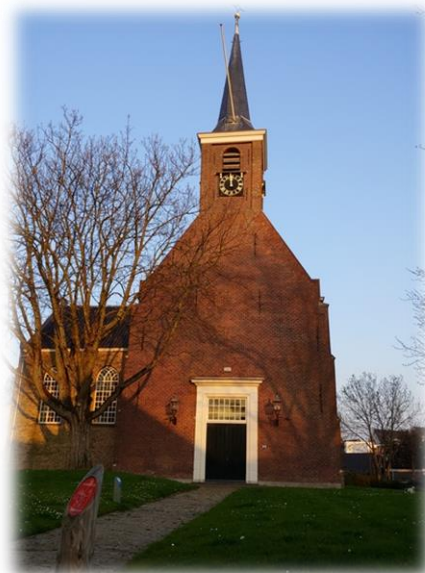
Het uurwerk is na de afronding van de restauratie volgens plan stil gevallen. Het torenuurwerk staat op de avond van 8 april 2020 klaar om vanaf middernacht weer de tijd aan te geven, zoals dat al meer dan 410 jaar het geval is geweest.
