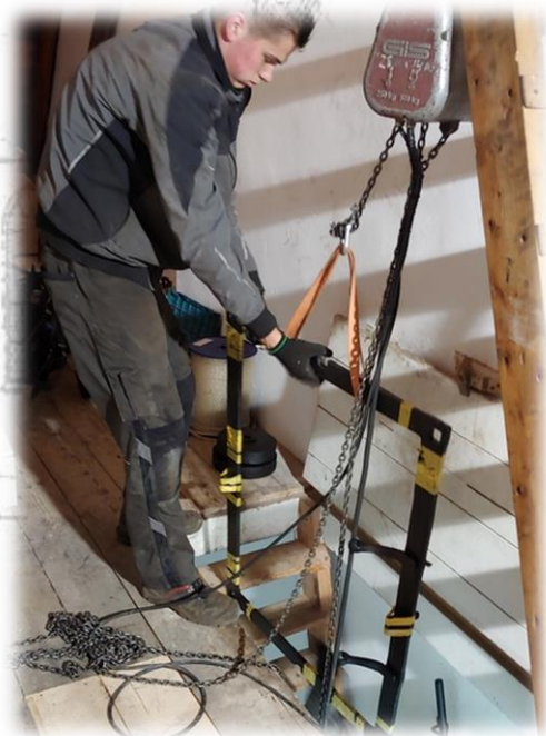
Het onderste uurwerkframe is bijna boven op de uurwerkzolder.
